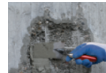
7 Morteros de reparación
